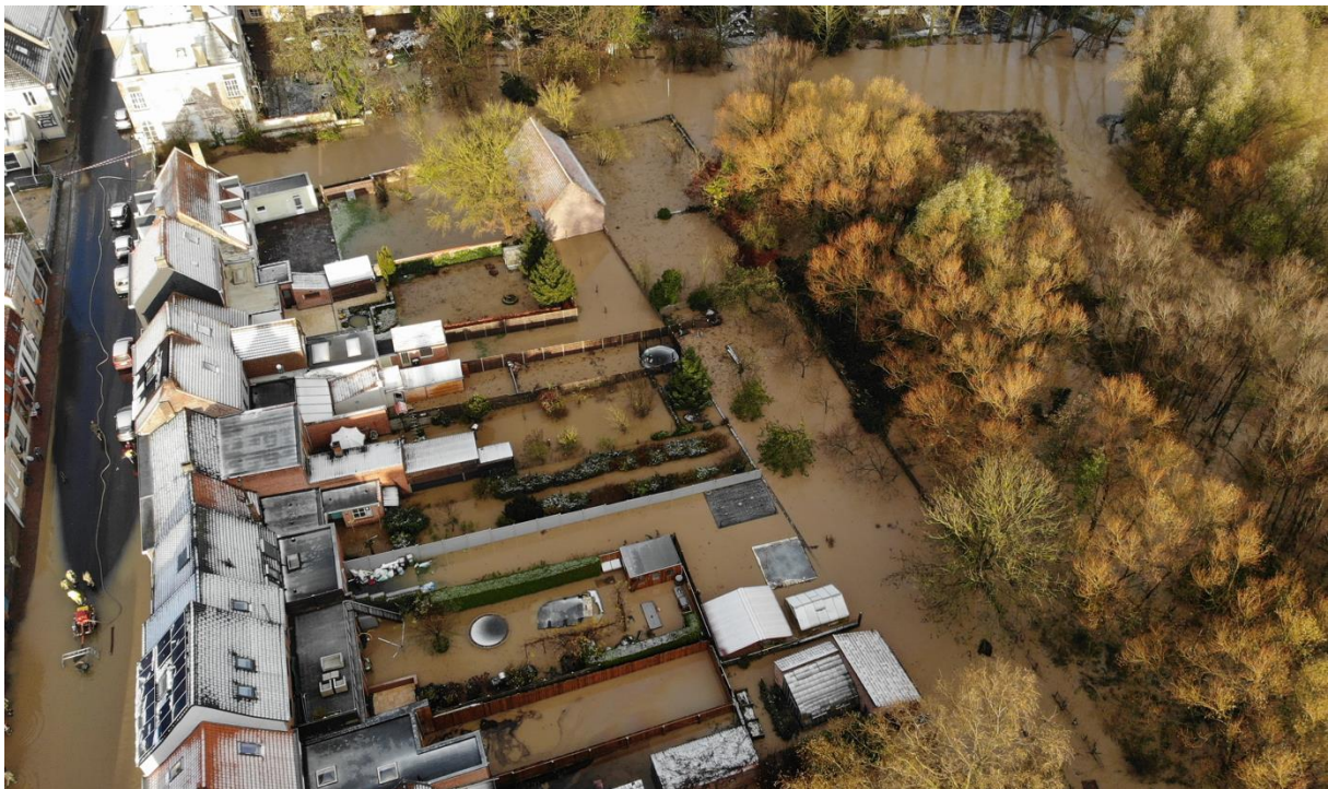
Foto keermuur Roesbrugge
